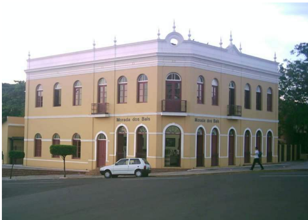
Foto 3 – Vista frontal do Casarão
